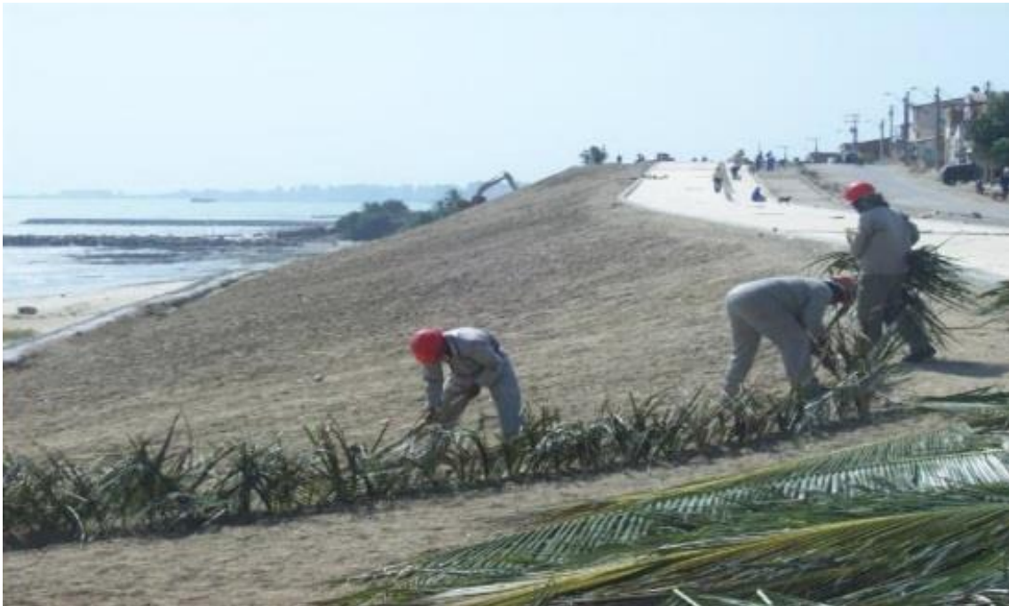
Figura 4 - Ancoragem (fixação de palha) e plantio de salsa nos taludes que margeiam os calçadões no Projeto Vila do Mar (2011), em Fortaleza/CE
