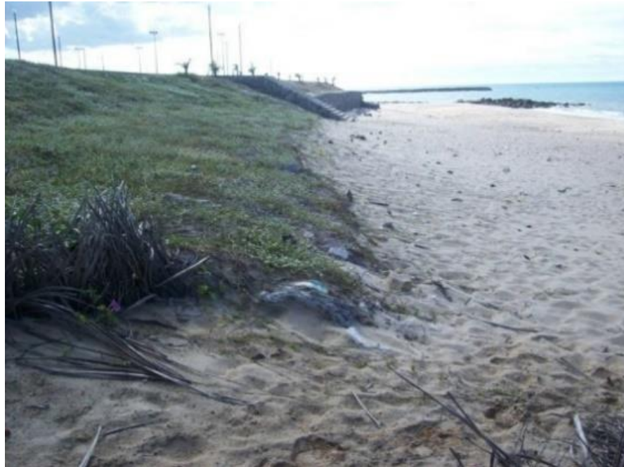
Figura 9 - Ancoragem com Rip-Rap Vegetal em áreas de talude vizinhas aos arrimos em gabião, em processo de construção e já com cobertura vegetal bem desenvolvida, no Projeto Vila do Mar.
