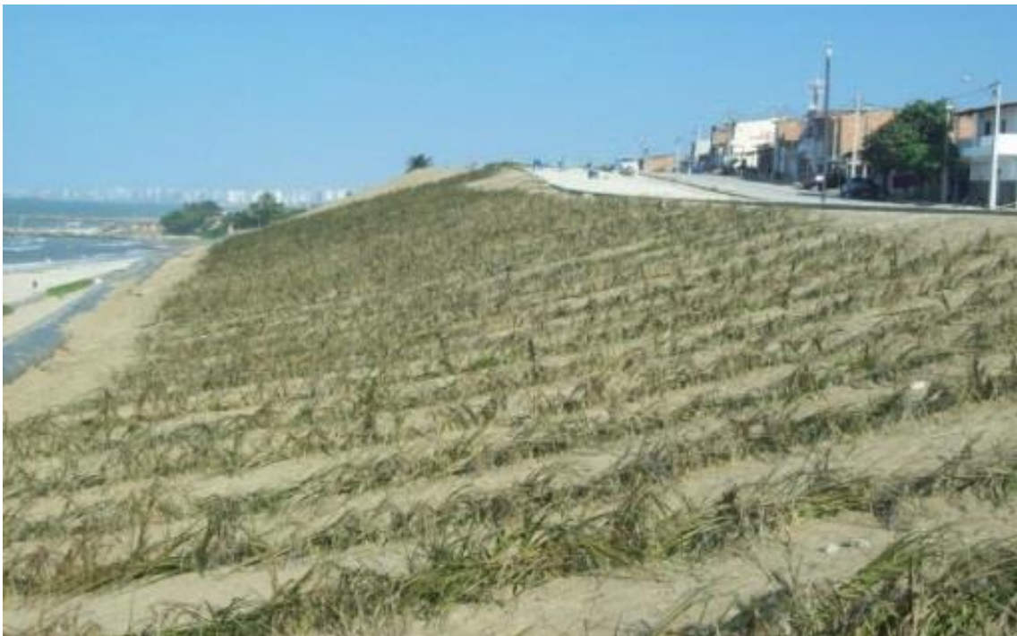
Figura 5 - Ancoragem (fixação de palha) e plantio de salsa nos taludes que margeiam os calçadões no Projeto Vila do Mar (2011), em Fortaleza/CE
