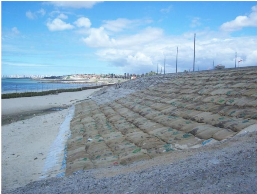
Figura 8 - Ancoragem com Rip-Rap Vegetal em áreas de talude vizinhas aos arrimos em gabião, em processo de construção e já com cobertura vegetal bem desenvolvida, no Projeto Vila do Mar.
